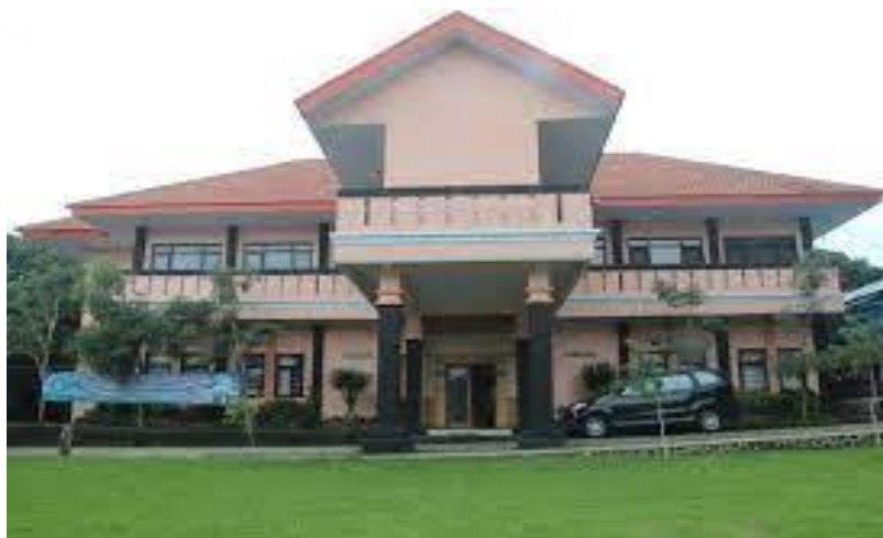
Gambar 1.2: Gedung Utama SMAN 1 Purwosari
