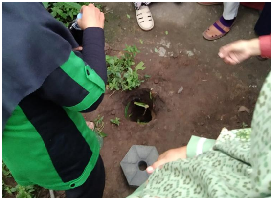
Gambar 3. Pembuatan Biopori
