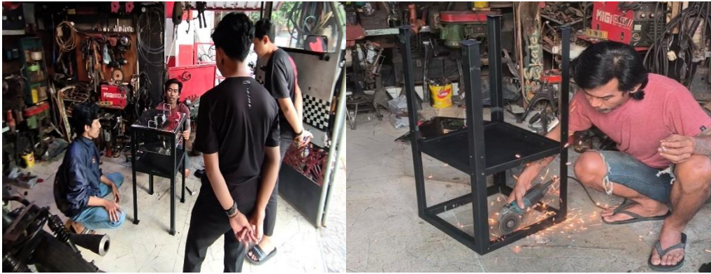
Gambar 1. Pemasangan Sistem Pemanas
