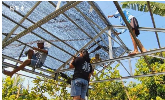
Gambar 2. Pemasangan paranet
