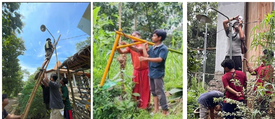
Gambar 2 Pemeliharaan instalasi listrik
