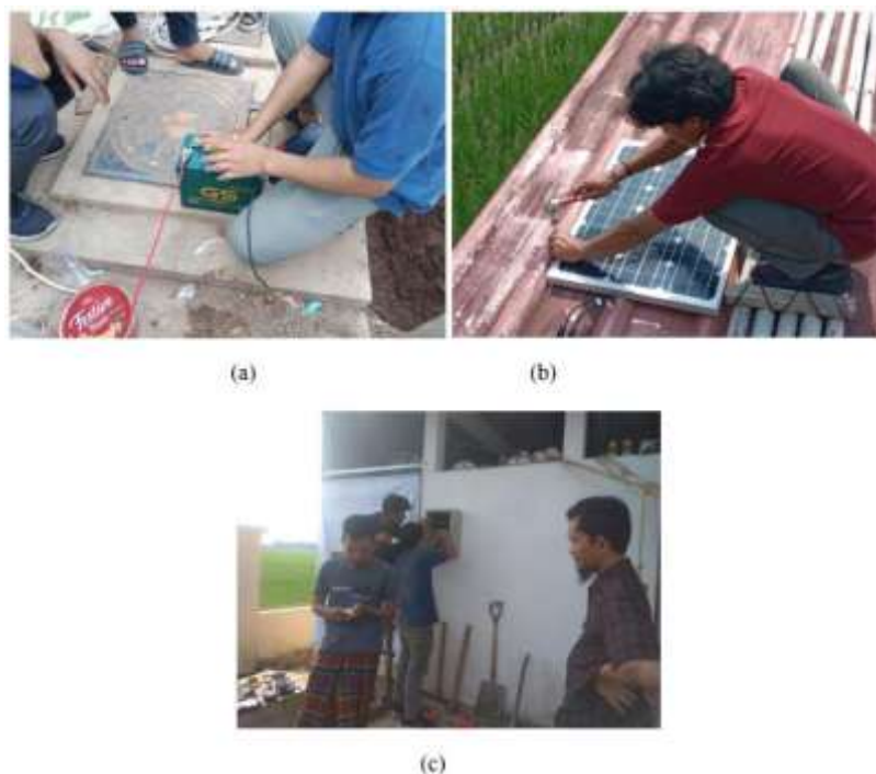
Gambar 3. Pelatihan Pemasangan Panel Surya.
