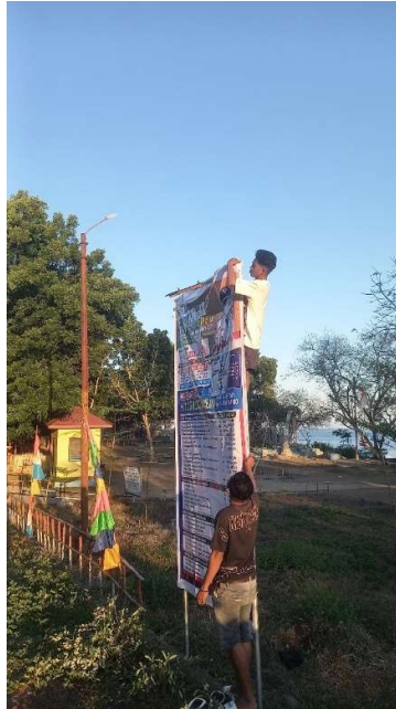
Gambar 2. Pemasangan Papan Informasi
