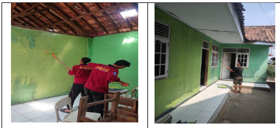
Gambar 2. Pengecatan Tembok Ruang Kelas Bagian Luar dan Bagian Dalam pada Madrasah Diniyah Al-Jauharotunnaqiyyah
