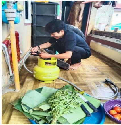
Gambar 2. Proses pemasangan tabung & gas
