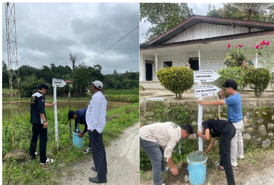
Gambar 7. Pemasangan petunjuk jalan di desa Nalela
