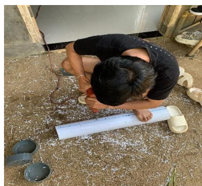
Gambar 3. Pelubangan Pada Pipa Paralon
