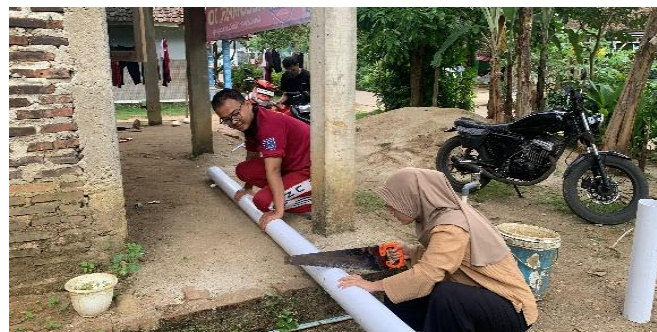
Gambar 2. Pemotongan Pipa Paralon Sepanjang 65cm
