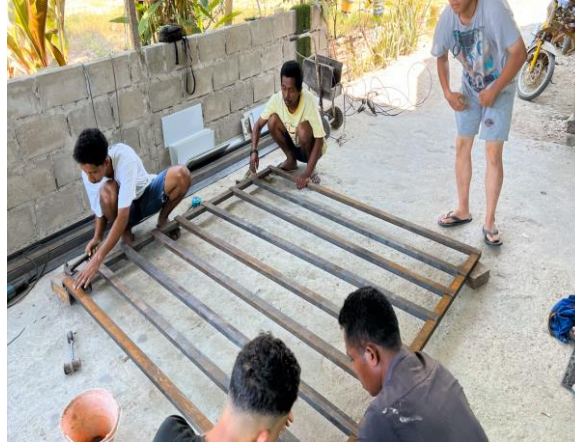
Gambar 5. Proses pembangunan menara filter air
