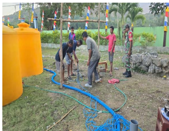
Gambar 8. Proses penggalian, pemasangan pompa, dan pemipaan
