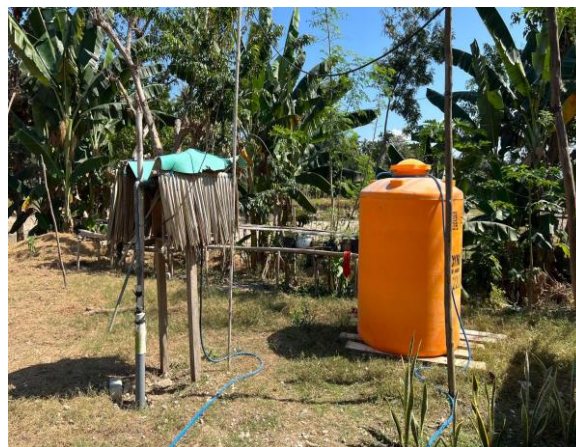
Gambar 2. Kondisi filter air sebelum renovasi
