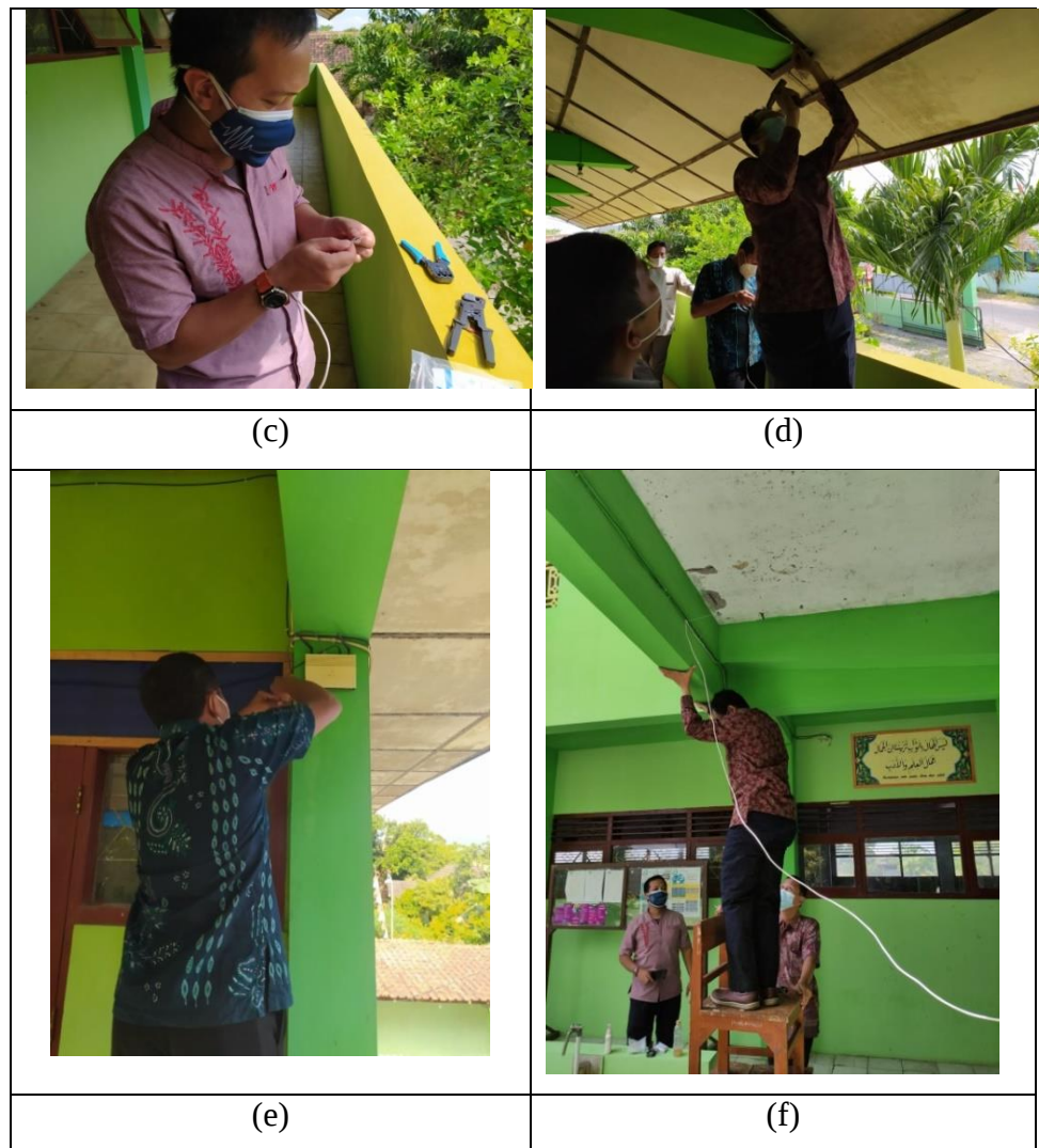
Gambar 5. Crimping dan Pengkabelan untuk menghubungkan antar Router Access Point
