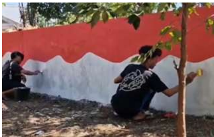
Gambar 3. Proses pengecatan dinding vertikultur
