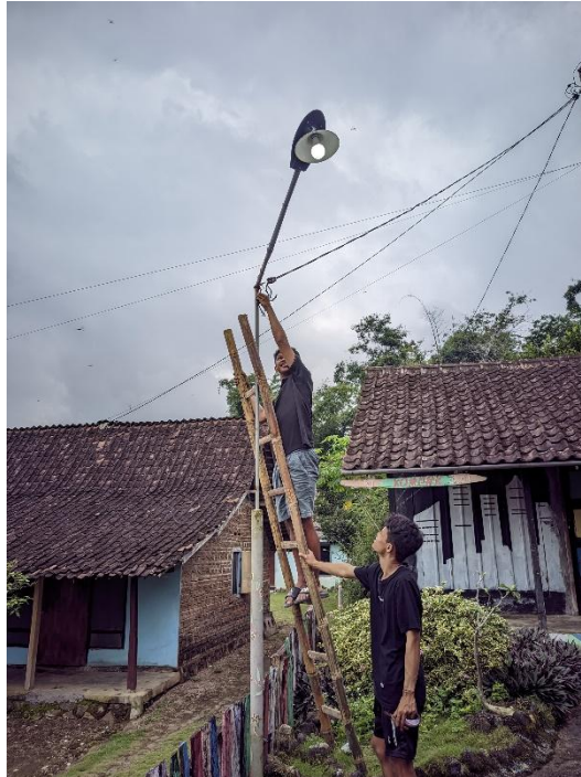
Gambar 7. Pemasangan Lampu Otomatis
