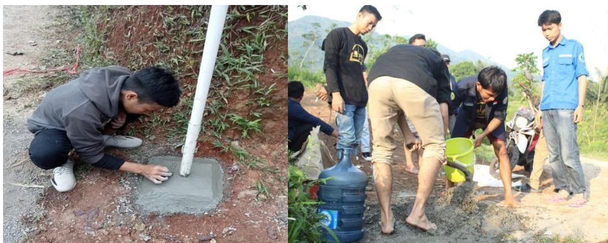
Gambar 4. Kegiatan Praktik Pembuatan dan Pemasangan Tiang Lampu Penerangan.
