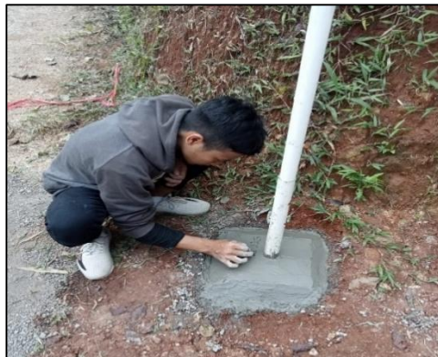
Gambar 4. Pemasangan Lampu Jalan.
