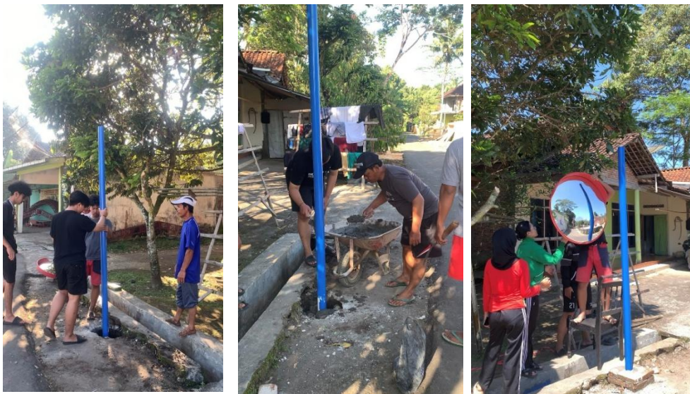
Gambar 3. Proses Pemasangan Convex Mirror
