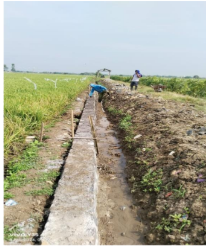
Gambar 5. Pembangunan pipa pompa air
