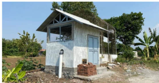
Gambar 6. Bangunan rumah pompa air
