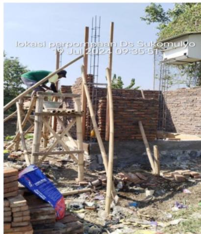
Gambar 4. Pembangunan rumah pompa air
