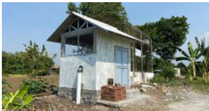
Gambar 6. Bangunan rumah pompa air
