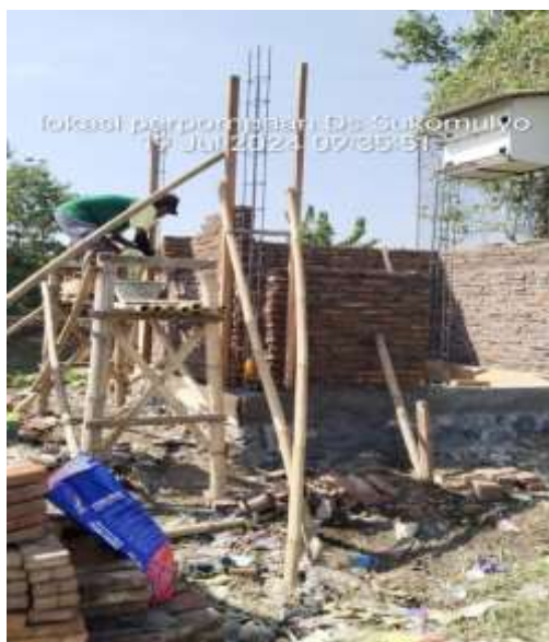
Gambar 4. Pembangunan rumah pompa air
