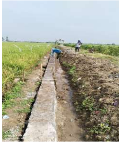
Gambar 5. Pembangunan pipa pompa air
