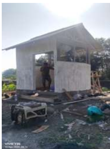
Gambar 1. Pembangunan rumah pompa air untuk pengairan sawah (Muhson, 2024)
