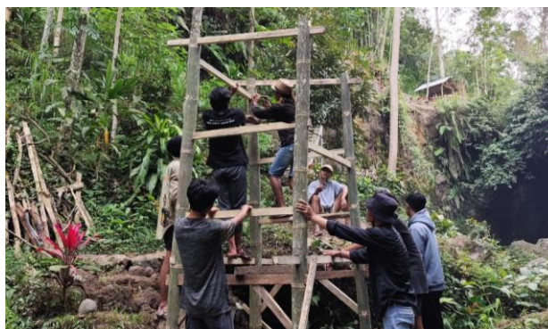
Gambar 2. Pembuatan kerangka Ruang Ganti
