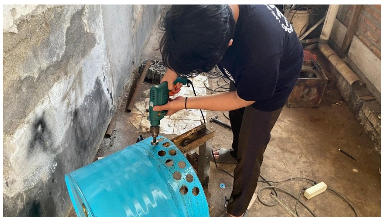
Gambar 4 Membuat Lubang Ventilasi
