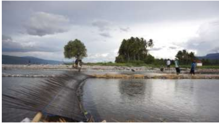
Gambar 2. Hirok Yang Terpasang Di Bilah Bambu Dan Perbaikan Alahan.
