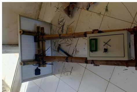
Gambar 5. Perakitan Panel Surya dan Panel Box ke Tiang Bambu
