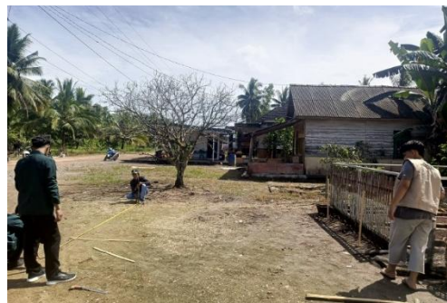
Gambar 3. Pengukuran Titik Pemasangan Lampu Jalan oleh Tim di Lokasi
