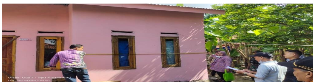
Gambar 3. Pembangunan Infrastruktir Permukiman Desa Bonisari
