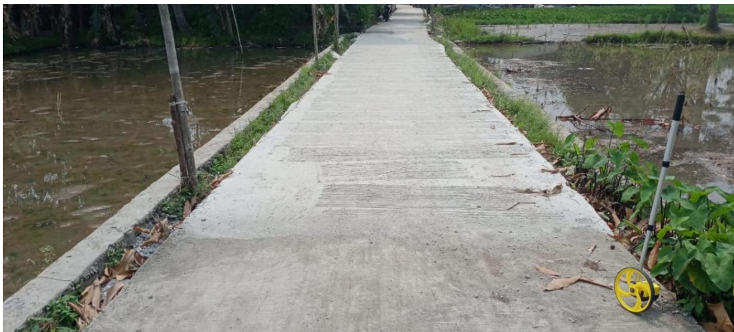
Gambar 1. Pembangunan Infrastruktur Jalan Desa Bonisari
