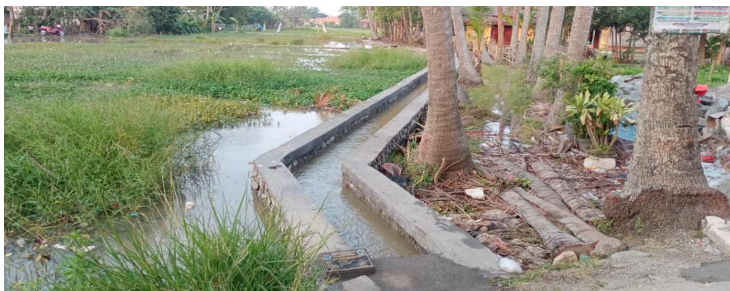
Gambar 2. Pembangunan Infrastruktir Irigasi Desa Bonisari
