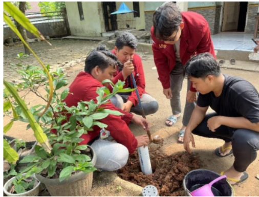
Gambar 4. Proses Pemasangan Lubang Biopori
