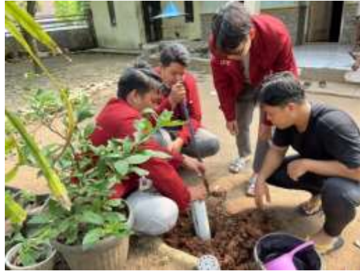
Gambar 4. Proses Pemasangan Lubang Biopori
