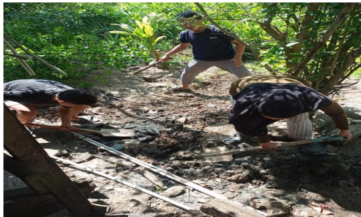
Gambar 3.1. Dokumentasi Pembuatan Saluran Pembuangan Air Limbah (SPAL)
