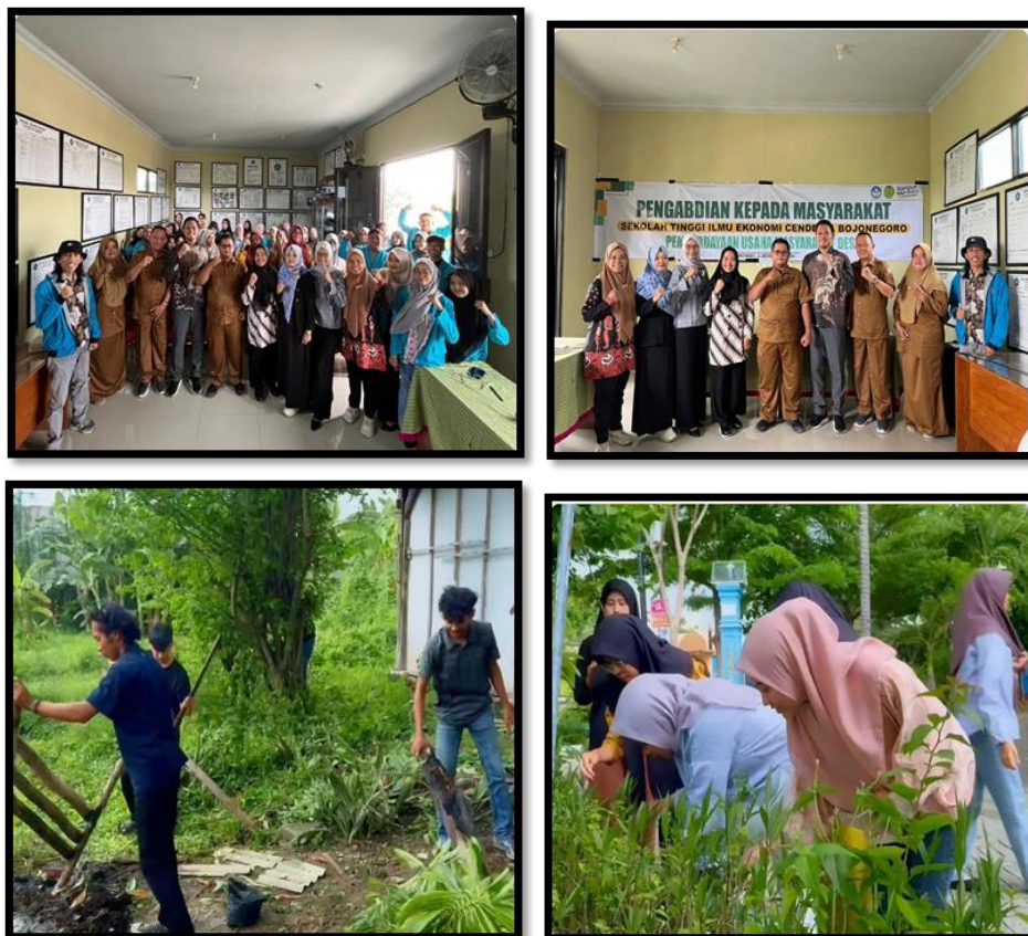
Gambar 3. Pembukaan, Pembersihan Tempat Yang Akan Didirikan GreenHouse
